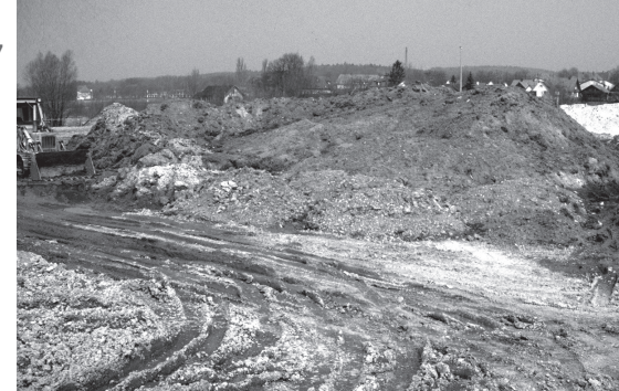
Bagger ebnen Auffüllmaterial in Göldern ein (1986)
