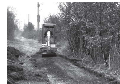
Mit dem Minibagger wird die Grasnarbe entfernt (1997)
